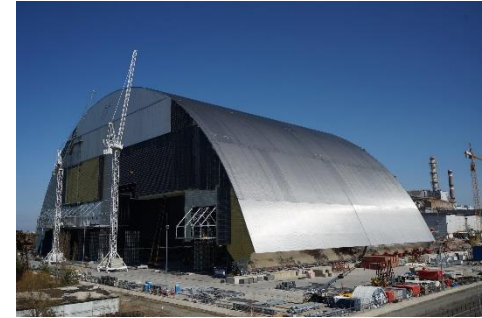
Chernobyl (Bóveda de contención)
